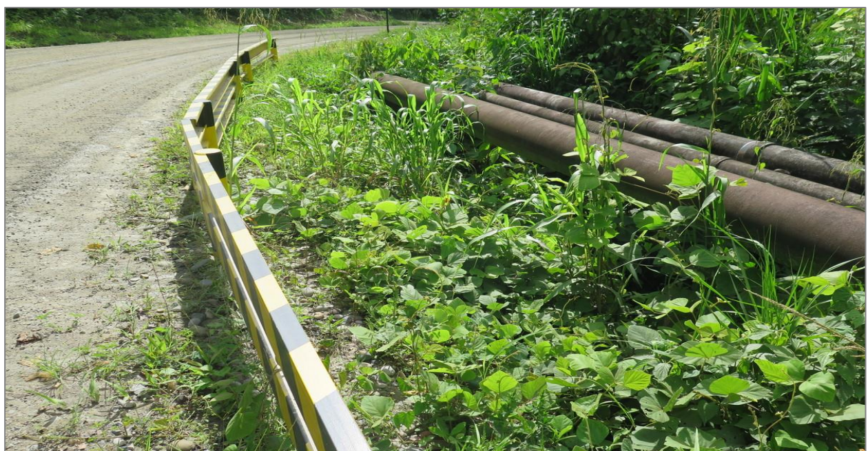
Figura 193: Registro de kudzu en la vía que conecta la Planta de Gas Malvinas con su aeródromo
