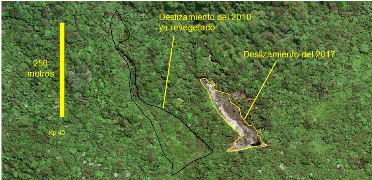
Figura 4: Deslizamiento en la progresiva Kp-40+600 en el 2017
